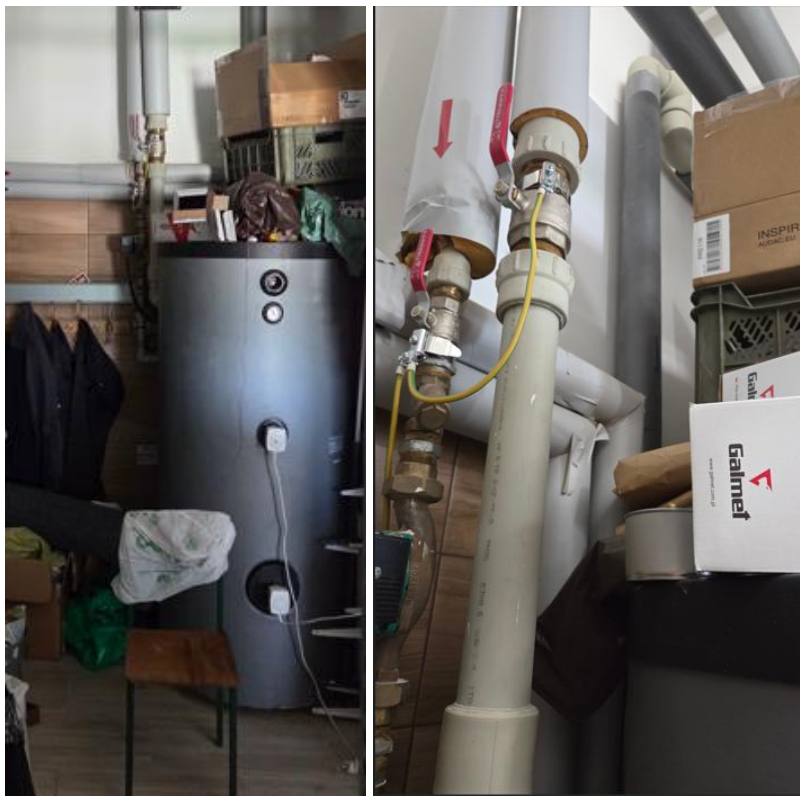
Fot. nr 6. Istniejący zbiornik ciepłej wody oraz instalacje przynależne
